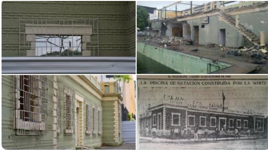
Figura 26. Demolición de piscina municipal patrimonio de Guayaquil
