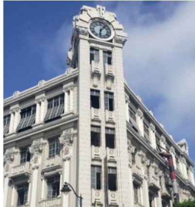
Figura 27. Edificio de antiguo diario El Telégrafo, hoy Universidad de las Artes
