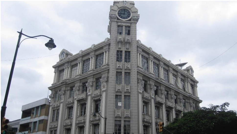
Figura 42. Edificio de Diario "El Telégrafo"
