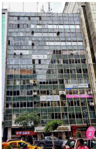
Figura 67. Edificio Gran Pasaje
