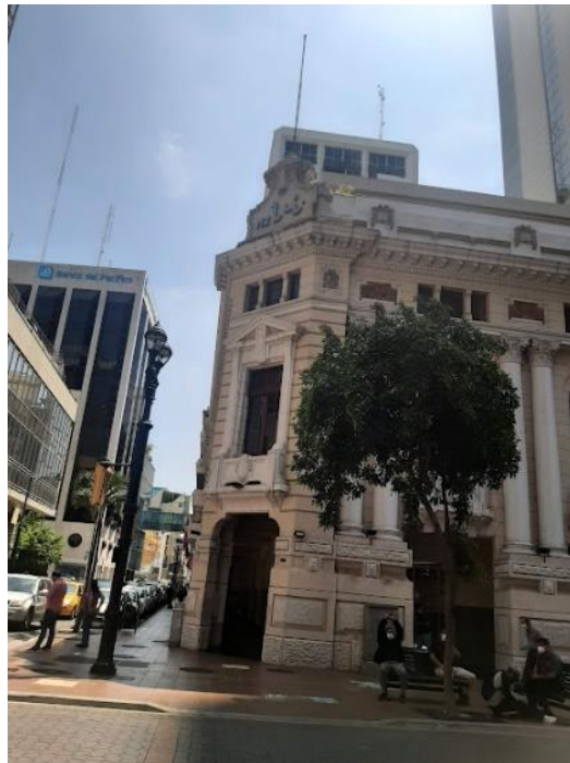
Figura 44. Antiguo edificio del Banco La Previsora
