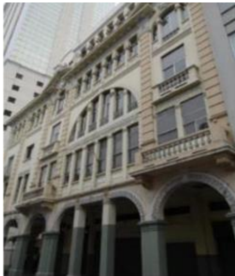
Figura 21. Edificio Malecón 1009 V.M. Rendón, 1925-1930
