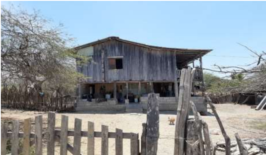
Foto 4. Casa en Cauchiche, de construcción mixta.
